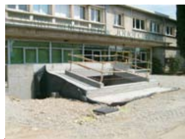
Construction d'une chaufferie bois, Ecole Joliot Curie
