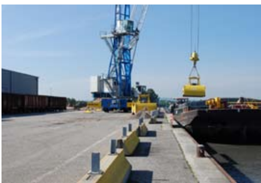
Port de commerce fluvio-maritime
