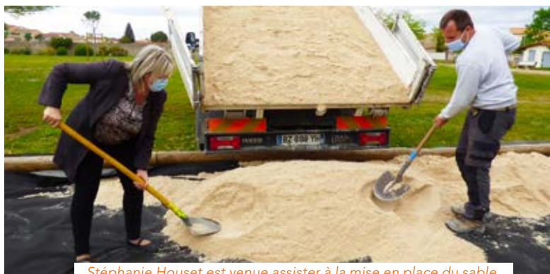
Stéphanie Houset est venue assister à la mise en place du sable.
