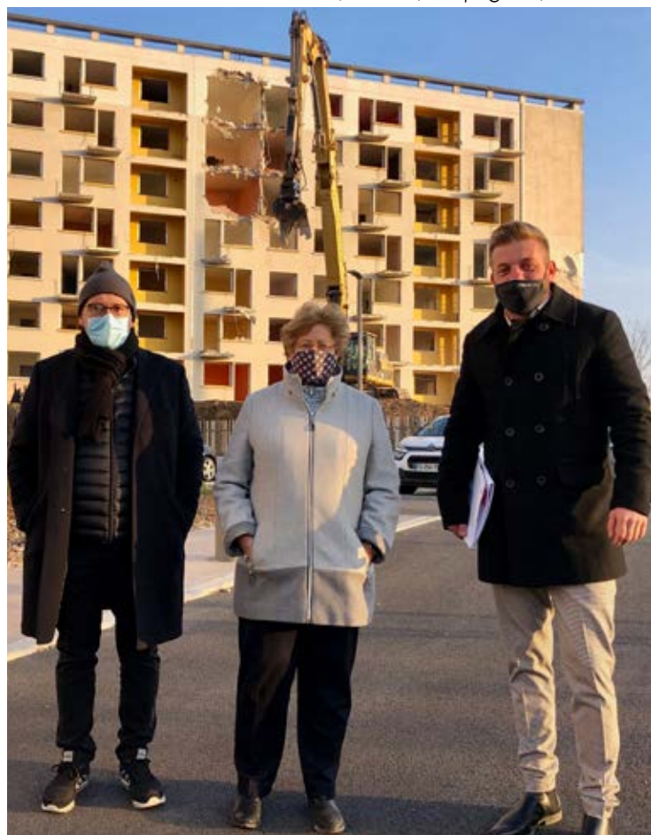
La destruction du bâtiment A des Descartes a débuté en présence d'Aurélien Esprit (président de Drôme Aménagement Habitat) de Bernard Buis (sénateur) et de Geneviève Girard, maire. (Voir page 13)
