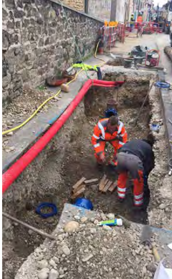
Les travaux de préparation ont commencé début mars, par le remplacement des canalisations d'eau en plomb et diverses bouches à clef d'eau potable comme sur le trottoir devant la Maison des associations.
