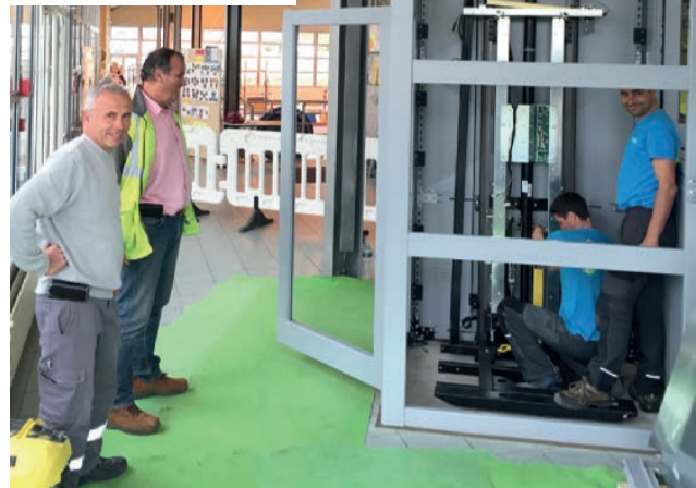
Joël Vieux, responsable du centre technique municipal, supervise l'installation d'un élévateur pour les personnes à mobilité réduite aux côtés de l'entreprise SEMA des Ollières sur Eyrieux en Ardèche
