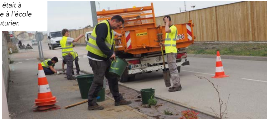
À la demande des riverains, les "coussins berlinois" de la rue Jean Macé (près de l'intersection avec la rue André Chastel), ont été remplacés par un dos d'âne.
